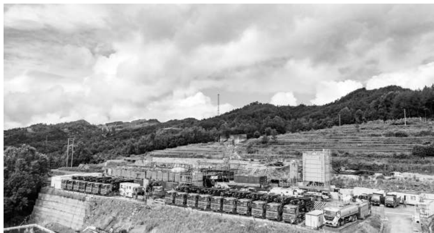
普光探区——普陆4井大型压裂施工现场
