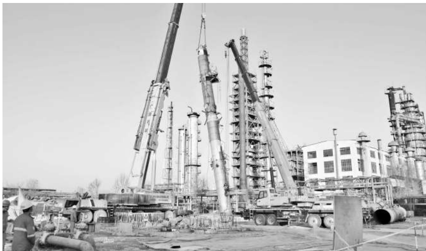
中国石化首个兆瓦级电解水制氢示范项目施工现场
