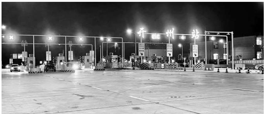
5月17日,台辉高速开州站投入使用
