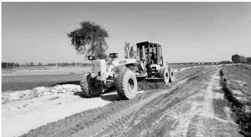
南乐县卫河右岸145+000堤顶刮平施工现场
