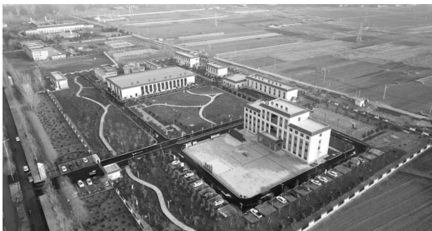
农村供水“四化”范县水厂全貌 (市水利局 供稿)
