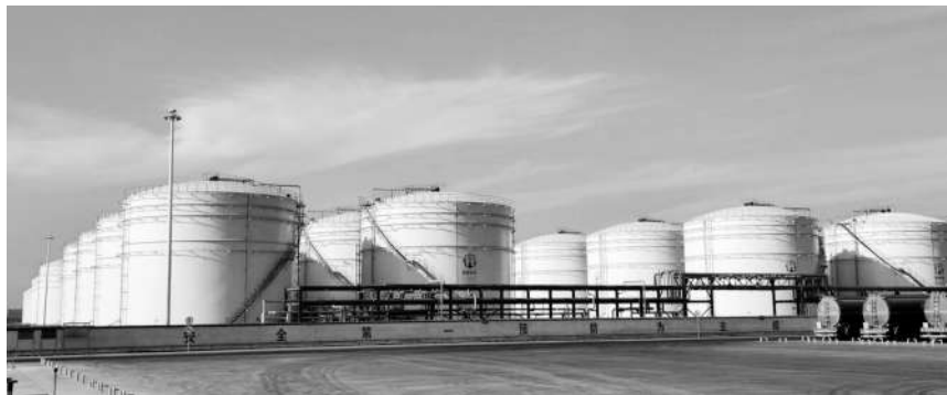
台前县恒润石化 20 万立方米仓储项目 (台前县委党史研究中心 供稿)
