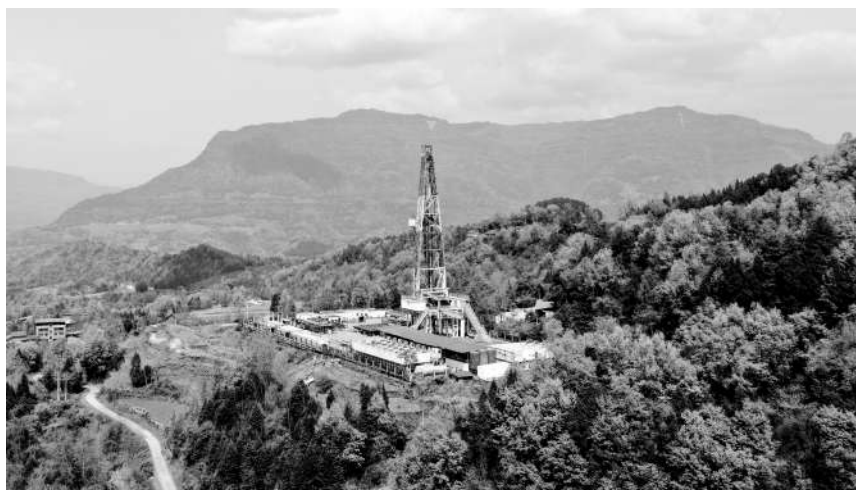
清溪1井施工现场
