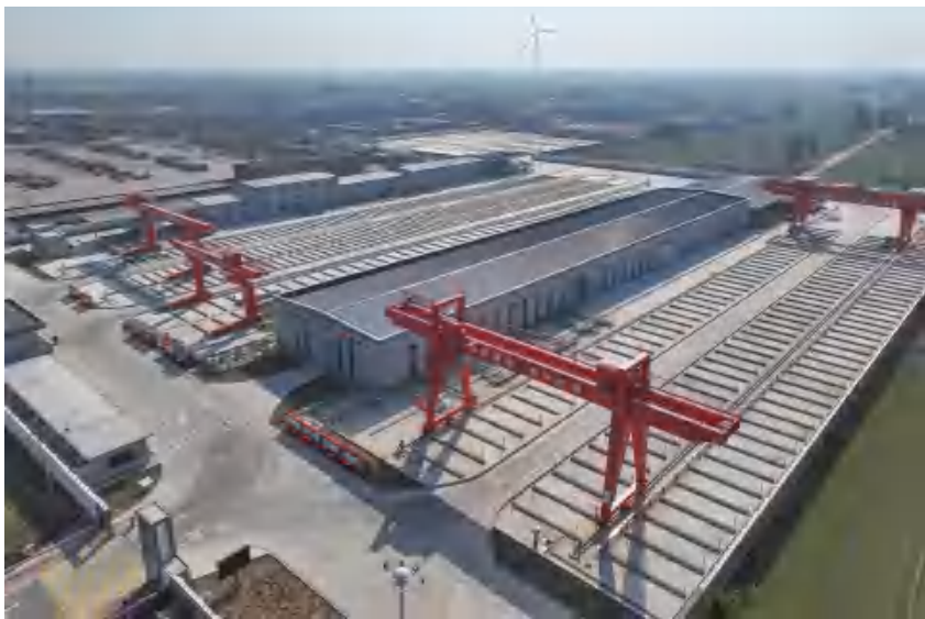
2024年10月19日，中原油田油管杆自动化修复基地建成投用
