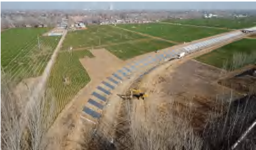
2024 年 12 月 7 日，南小堤灌区项目建设施工现场（市水利局 供）
