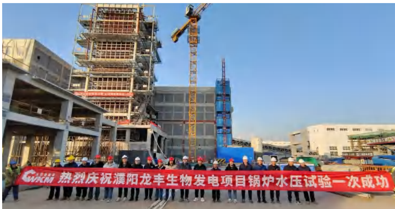
2024 年 12 月 31 日，濮阳龙丰生物发电项目锅炉水压试验一次成功
