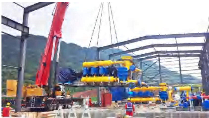
2024年7月4日，普光气田湿气增压工程2号增压站进行压缩机吊装作业 (于建设 摄)
