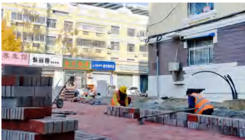
2024 年，市城区紫东花园小区 更新改造 （黄立 摄）
