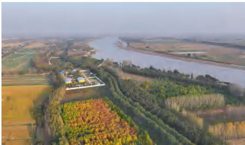
2024 年，位于范县李桥控导工程背河处的防汛料库
