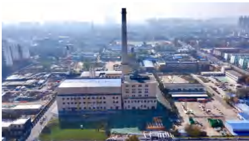
2024 年 11 月 28 日，濮阳绿色热源供应中心项目投入使用 (市城市管理局 供)
